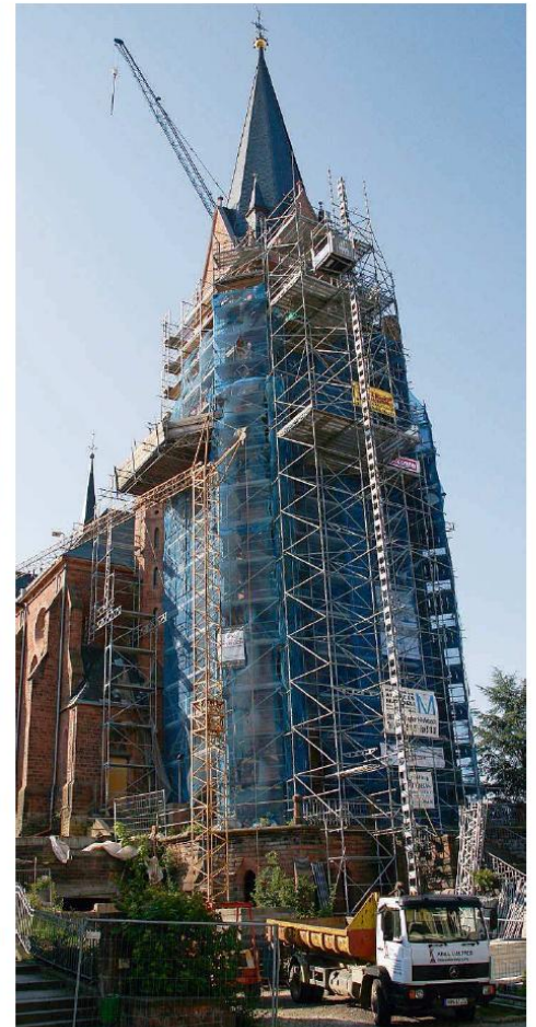
Auch außen trägt St. Josef teilweise noch Gerüst. FOTO: SCHNEIDER (1)
