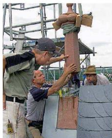
Sandsteinelemente werden auf dem Dach von Steinmetzen der Firma Hanbuch angebracht.
